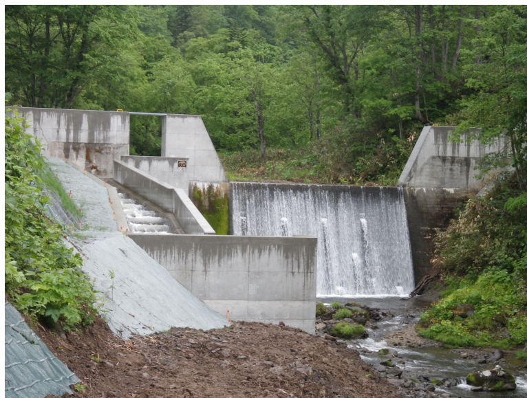
治山堰堤：土砂流出に対応した山脚固定のための構造物
