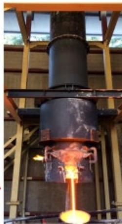
バイオマス循環型熱風キュボラ
