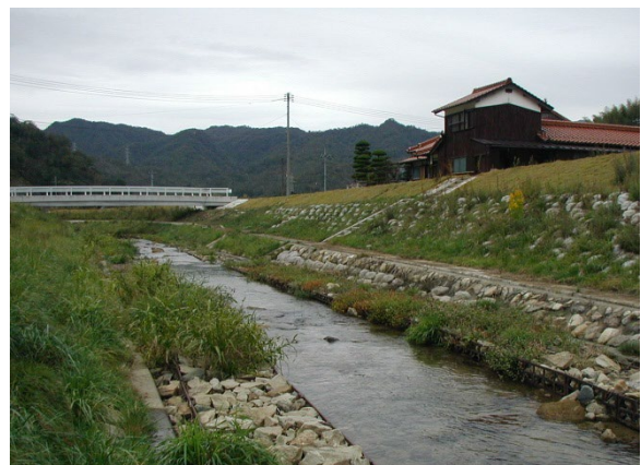
石と鑄鉄の根固工
