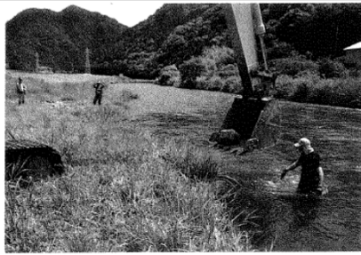
重機で投入される石と、指導を行う安田教授（右）＝17日、出雲市乙立町の神戸川
