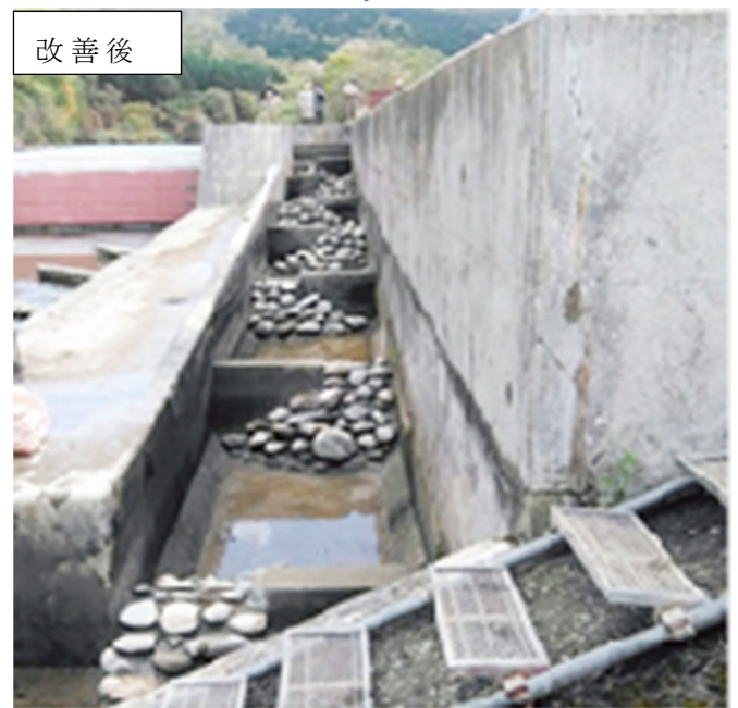
写真－4 魚道隔壁部の改善(住吉頭首工)
