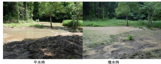
火薬庫の沢自然再生工事(2017.5)
