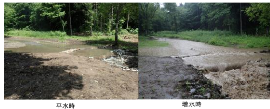
火薬庫の沢自然再生工事(2017.5)
